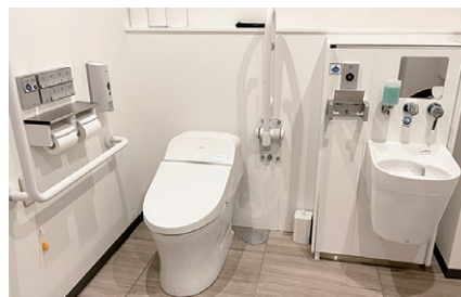
多機能な設備を配備したトイレの事例
