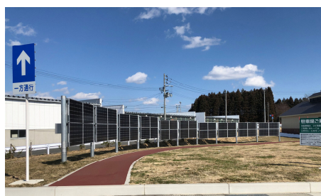
太陽光パネルの設置
