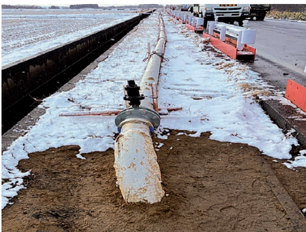
応急工事により仮設管を敷設（L＝320m）
