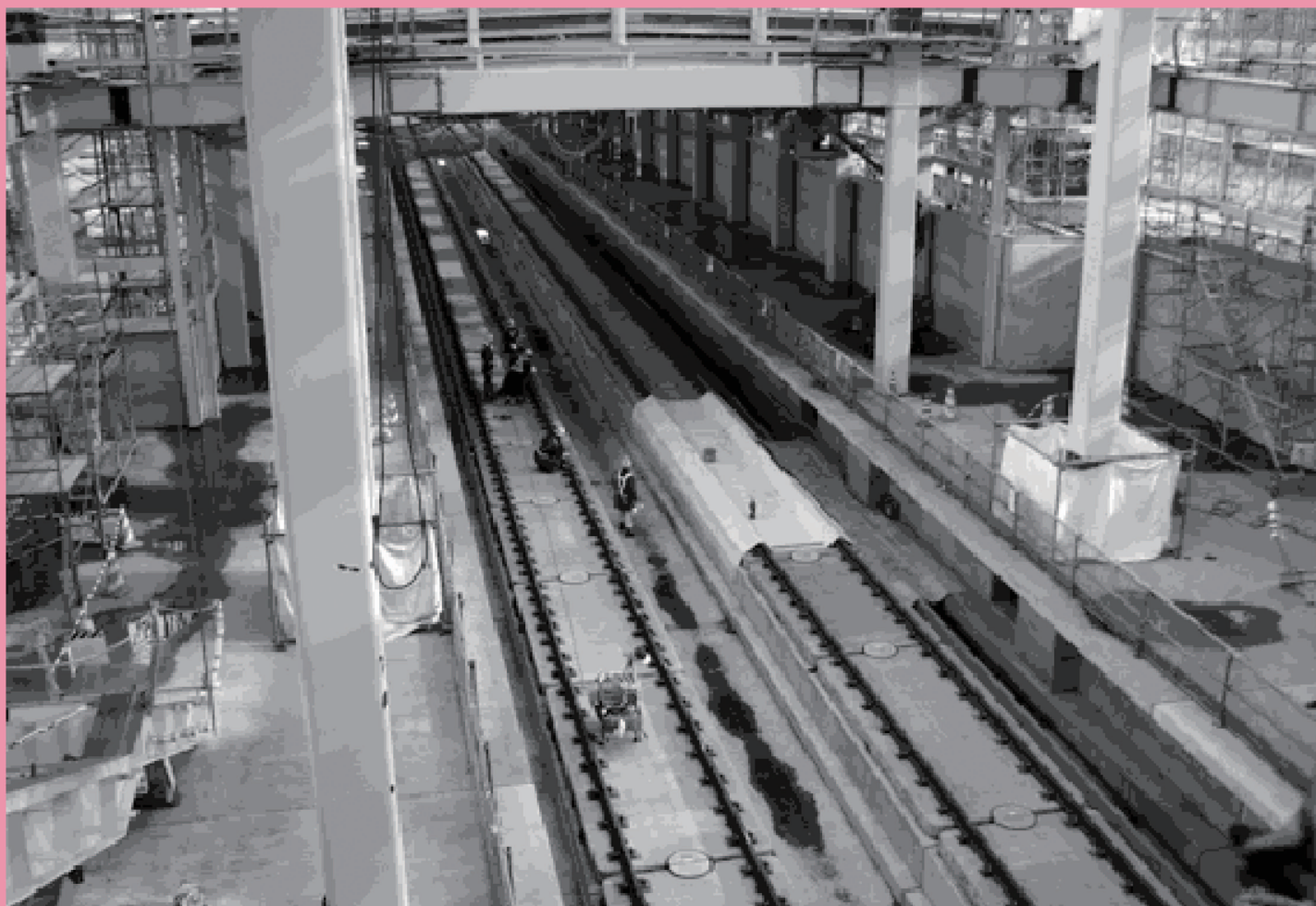
工事中の駅構内ホームの状況（平成 20 年 11 月 5 日議会新幹線対策特別委員会視察時）
