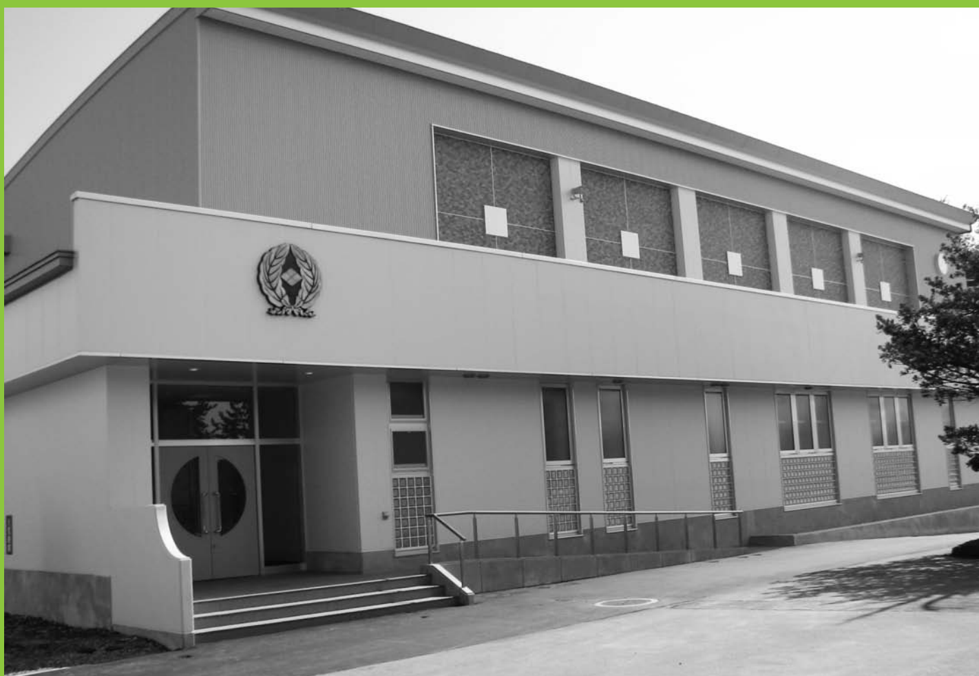
七戸小学校屋内運動場（体育館）完成する
