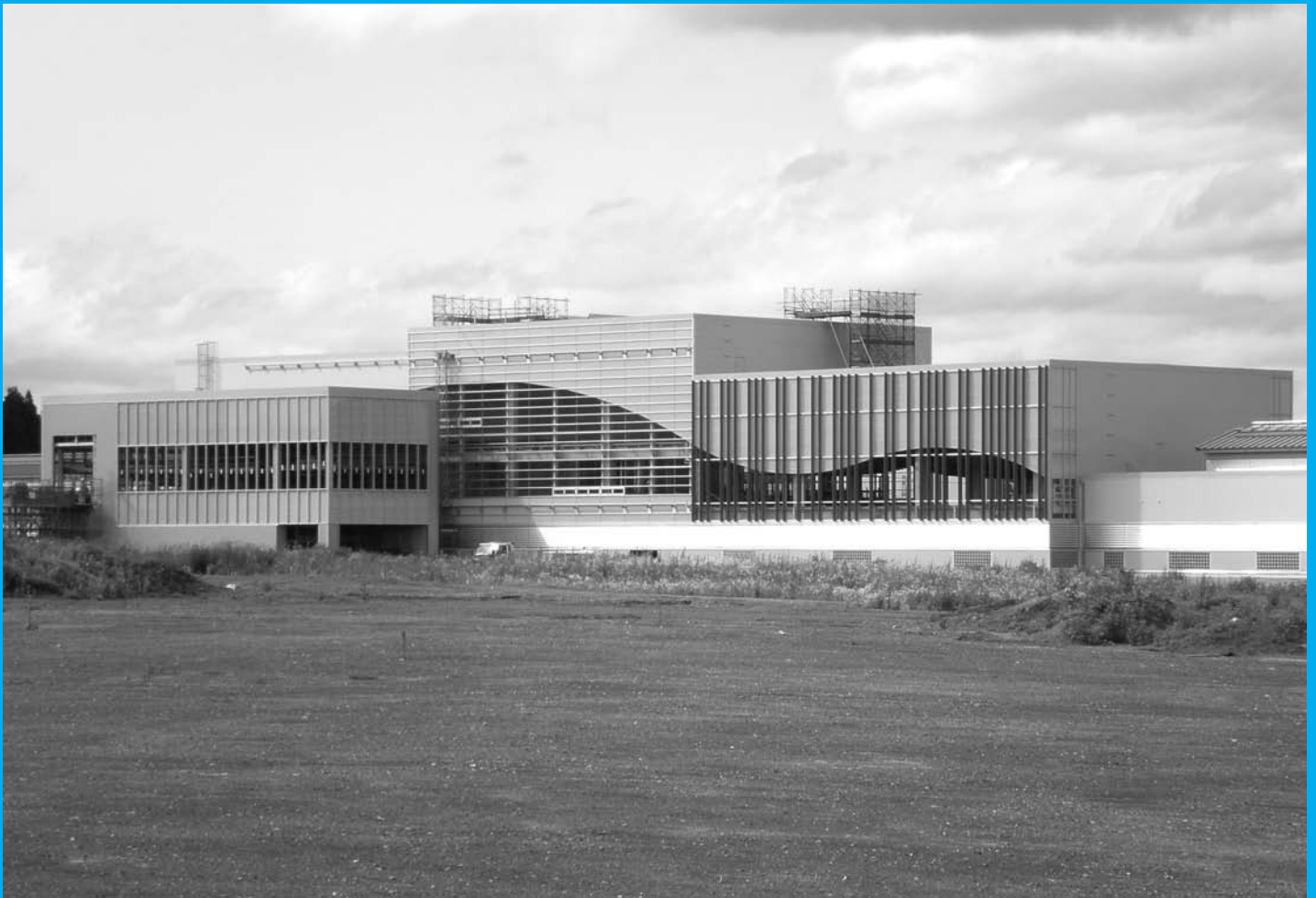
完成間近の七戸（仮称）駅（7月8日撮影）
