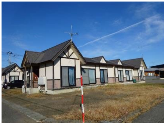
中野団地 (5号棟) 全景
