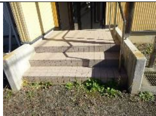
階段室タイル 概ね良好 (1号棟)
