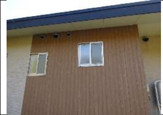
外壁 概ね良好 (1号棟)
