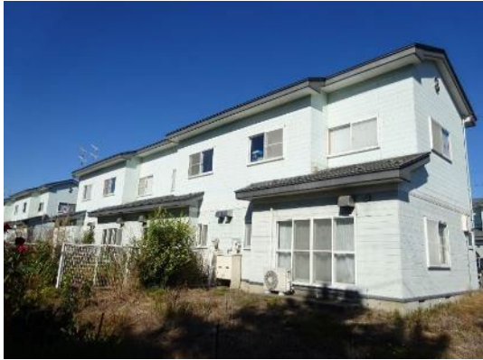
ききょう団地 (3号棟) 全景
