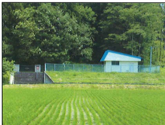
野々上浄水場
