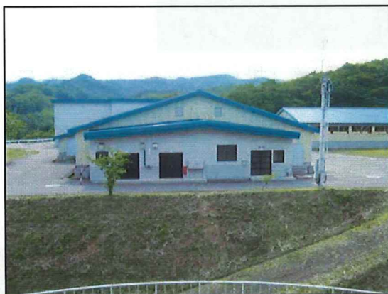
天間林第1浄水場
