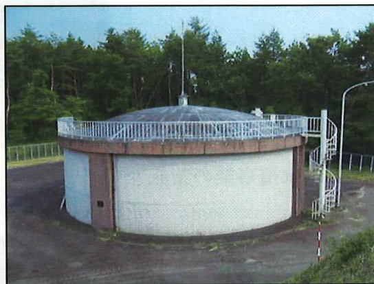
天間林第1配水池
