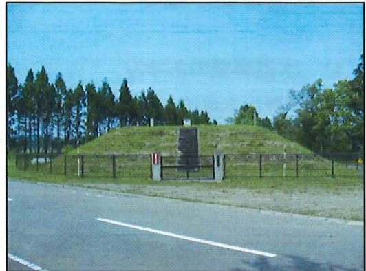
七戸低区配水場
