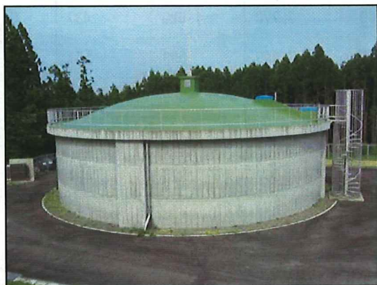
天間林第2配水池
