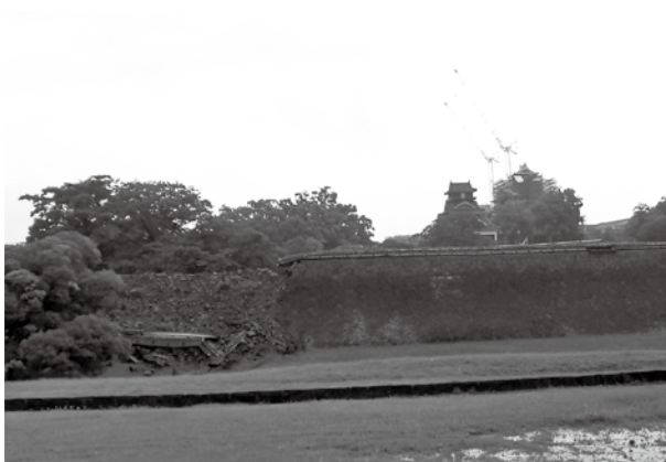
被災した石垣
