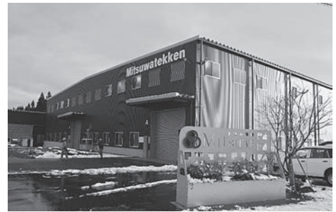
▲立野頭の事務所に隣接する本社新工場
