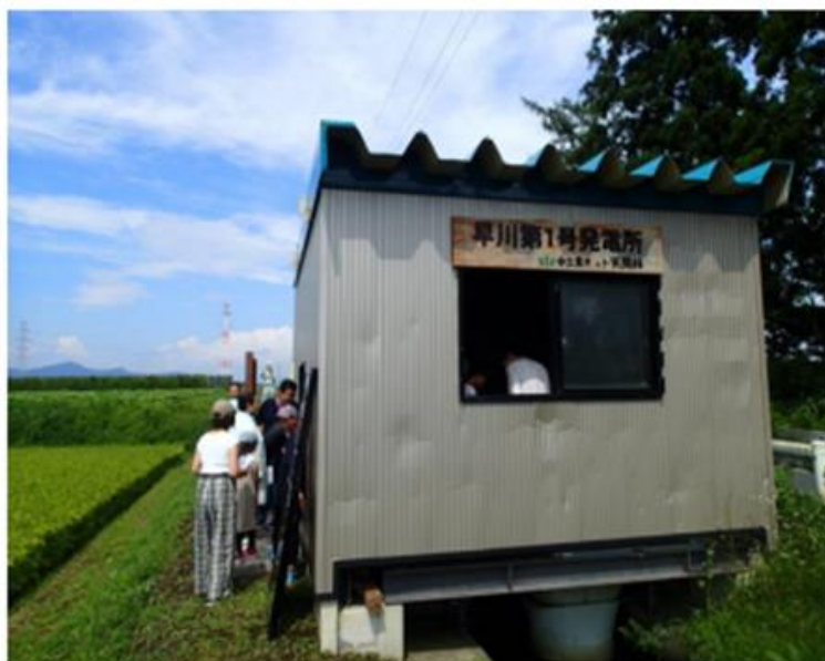
図 4-4 早川第 1 号発電所の外観
