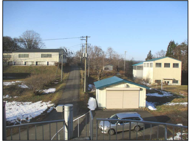
七戸浄水場(全景)
