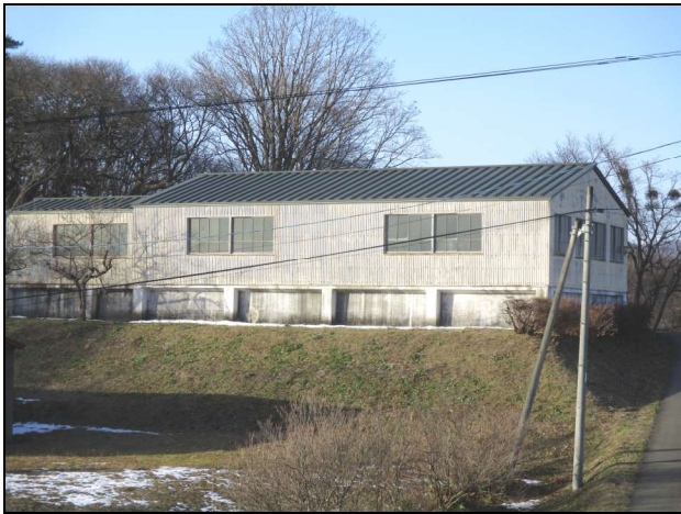
七戸浄水場(凝集沈殿池)
