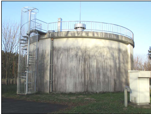
見町配水場(配水池)
