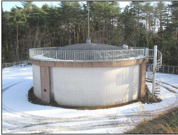
天間林第 1 浄水場(配水池 NO.1)
