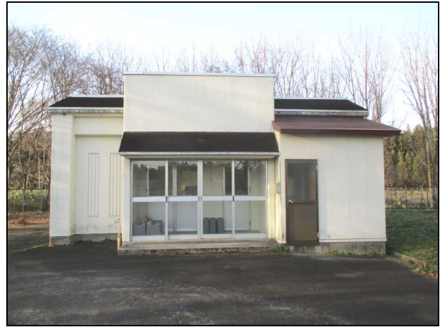
見町配水場(管理棟)
