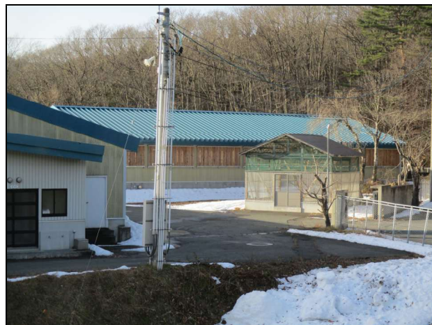
天間林第 1 浄水場(緩速ろ過池・管理棟)
