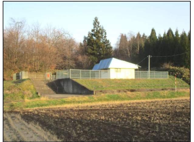
野々上浄水場
