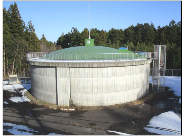
天間林第 1 浄水場(配水池 NO.2)
