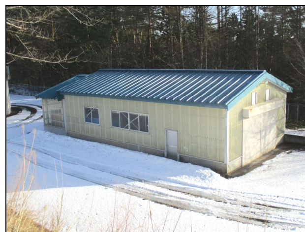
天間林第 1 浄水場(砂洗室)
