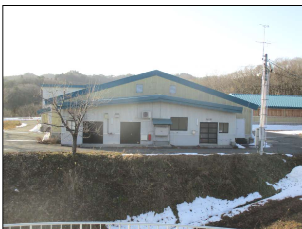
天間林第 1 浄水場(緩速ろ過池・管理棟)
