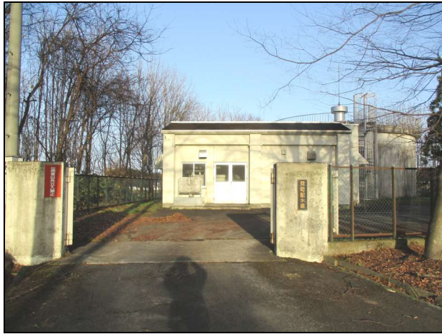
見町配水場(全景)
