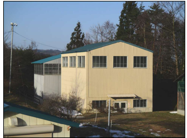
七戸浄水場(急速ろ過装置)
