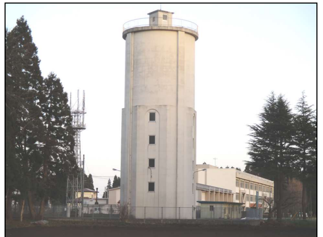
天間林第 2 浄水場(配水池)
