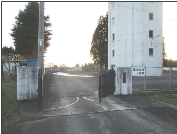
天間林第 2 浄水場
