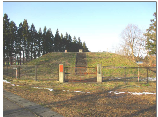
七戸低区配水場(配水池)
