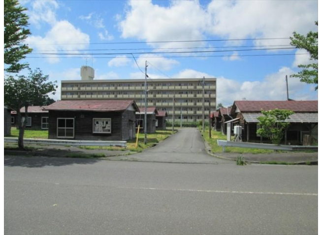
既存進入道路（奥：旧雇用促進住宅）
