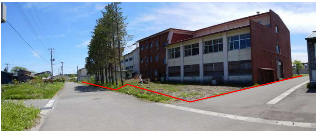
北 西 方 よ り 撮 影
