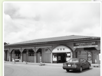
道の駅「しちのへ」の太陽光発電パネル
