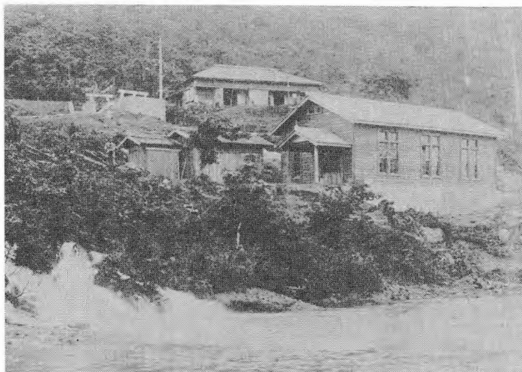
七戸水電株式会社坪川発電所
