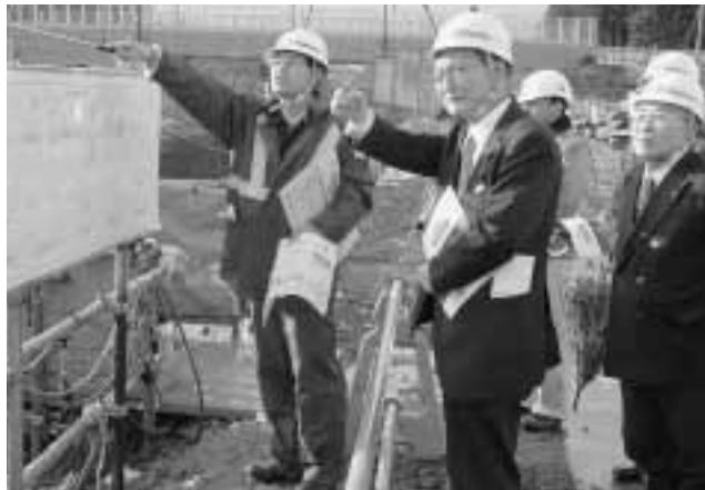
新幹線駅の建設現場を見学する「久慈一日町長」
