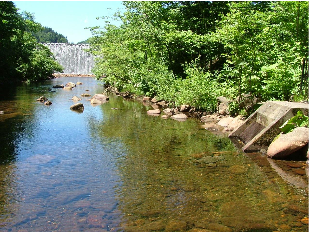
小坪川取水口
